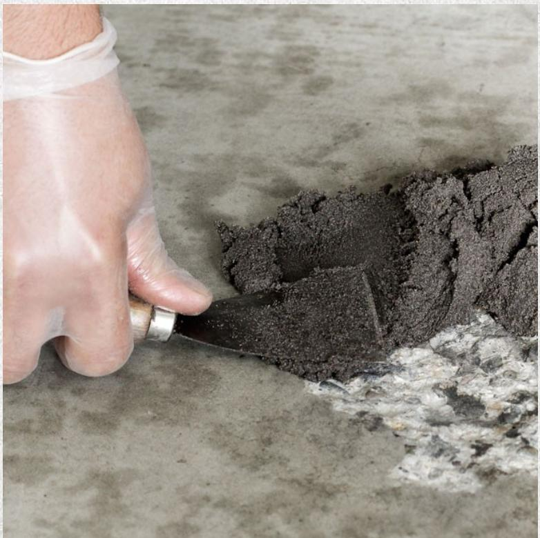
یک ملات اپوکسی سازه ای بدون حلal، بر پایه رزین اپوکسی اصلاح شده و هاردنرهای ویژه می باشد که به صورت دوجزی و نیکسوتروپیک و مناسب جهت اجرا در دمای ۵ تا ۲۵ درجه سانتیگراد طراحی شده است. این ماده بر اساس استاندارد ASTM C881 نوع ۱، ۲، ۳ و ۴ دسته طراحی شده و در تمامی مقاطع افقی و عمودی انواع سازه ها قابل اجرا می باشد.
